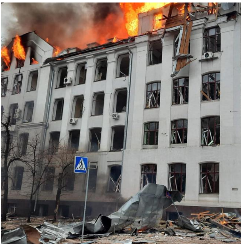
Devastazione senza tregua Il palazzo dei Servizi di sicurezza dell'Ucraina distrutto dai bombardamenti russi
